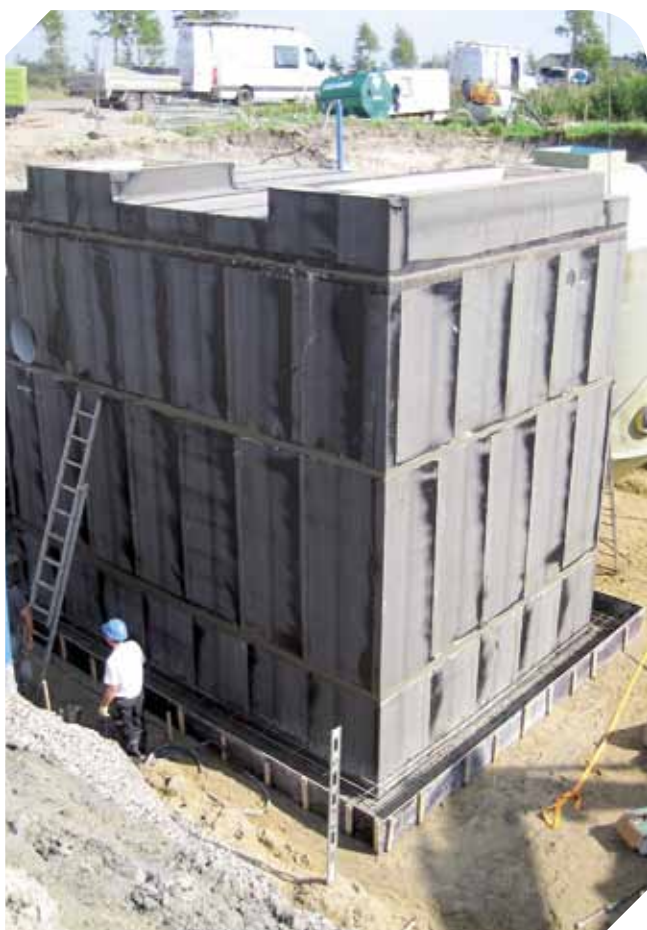
En specialitet fra RC er store boxelementer til underjordiske konstruktioner.
