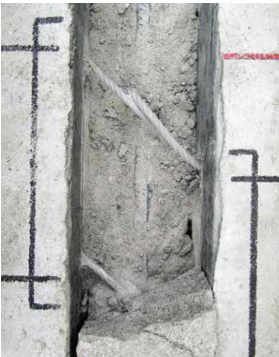
Elementerne samles med indstøbte wiresløjfer omkring en armeringsstang, hvorefter samlingen udstøbes med fugebeton.
